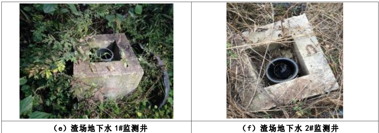
图 5.4-8 泉点和水井现场照片
